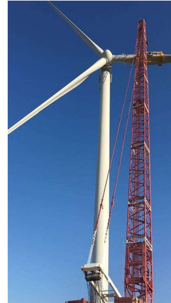
Figure 69 : Montage des pales (Source : VOLKSWIND)
