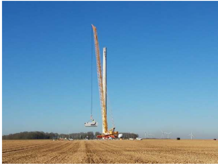
Figure 67 : Montage de la nacelle (Source : VOLKSWIND)
