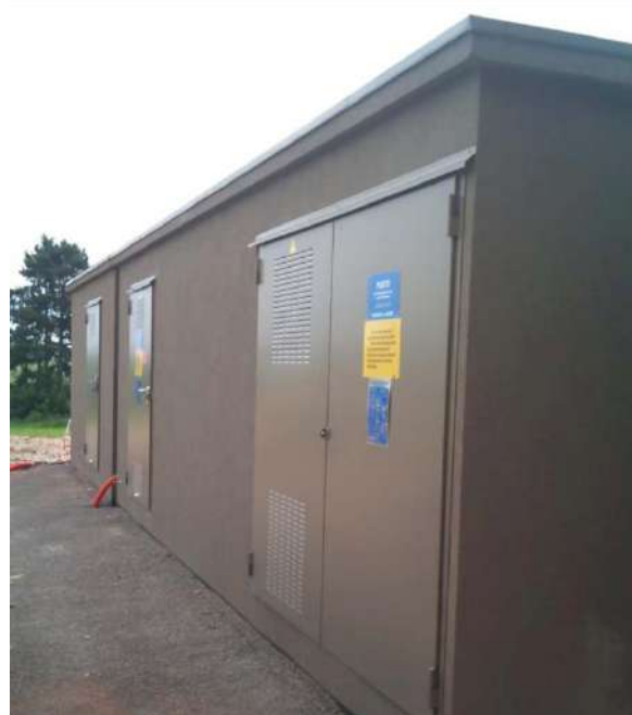
Figure 55 : Exemple de poste de livraison
