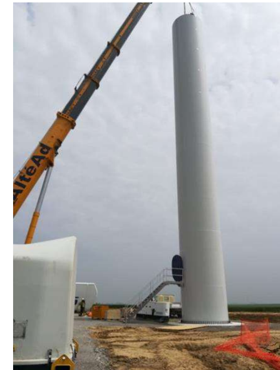
Figure 65 : Montage de la première section du mât (Source : VOLKSWIND)
