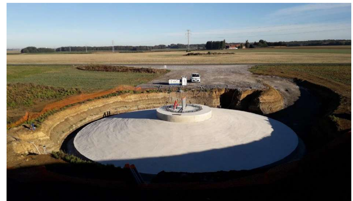
Figure 60 : Fondation après coulage béton
