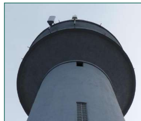
Figure 92 : Installation d'un réémetteur sur un château d'eau
