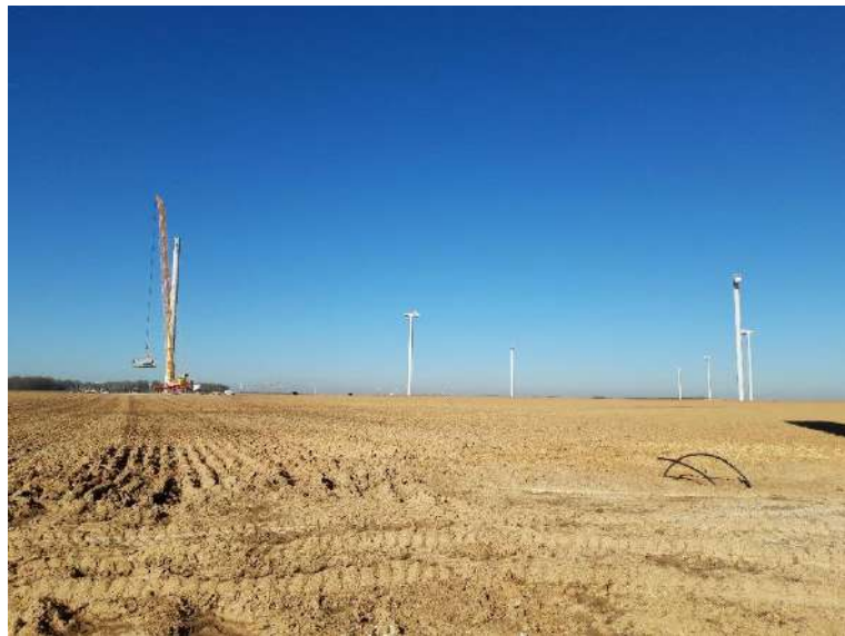
Figure 70 : Un parc de neuf éoliennes Vestas V112 en construction
