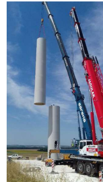
Figure 65 : Montage de la première section du mât (Source : VOLKSWIND)
