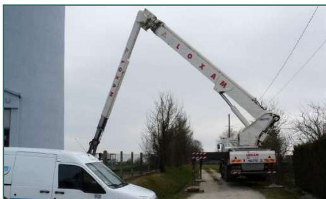
Figure 92 : Installation d'un réémetteur sur un château d'eau
