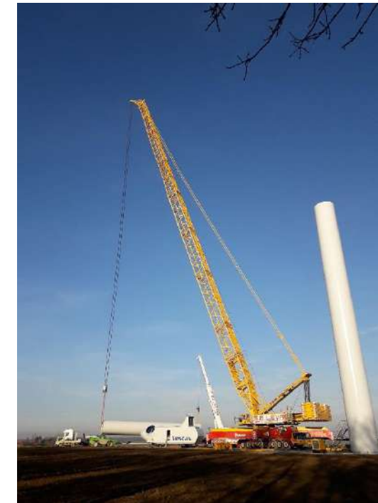
Figure 61 : Grue permettant l'assemblage des différents éléments d'une éolienne
