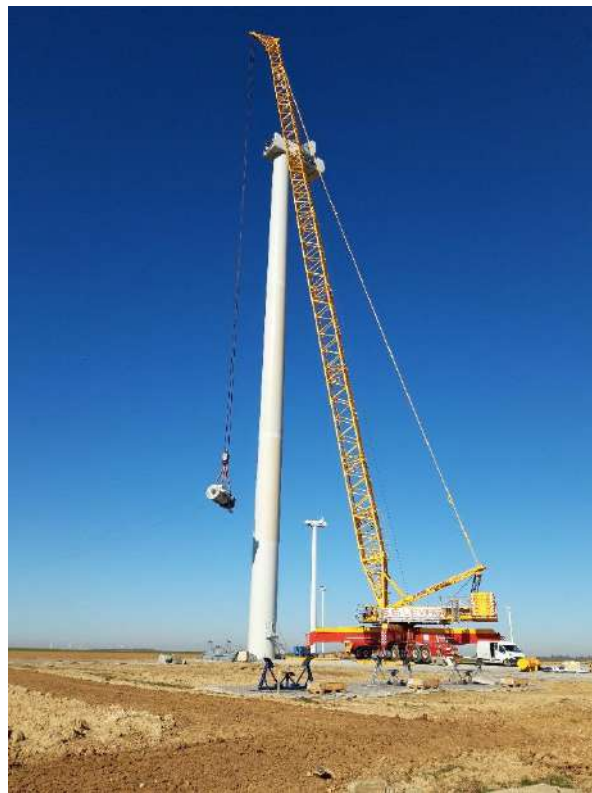
Figure 68 : Montage de la génératrice (Source : VOLKSWIND)
