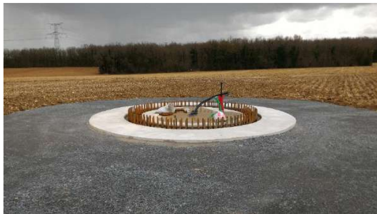
Figure 64 : Fondation finalisée (Source : VOLKSWIND)
