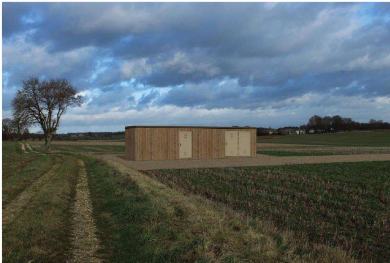
Figure 85 : Intégration du poste de livraison (Source : Agence COUASNON)
