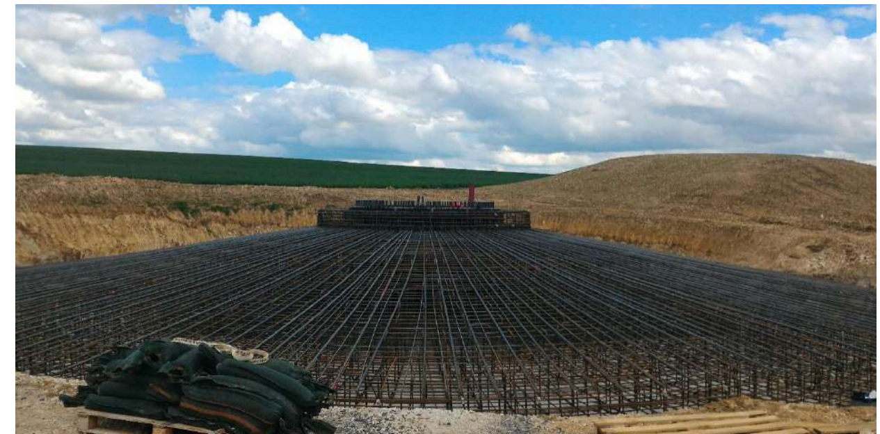
Figure 59 : Ferrailage du massif
